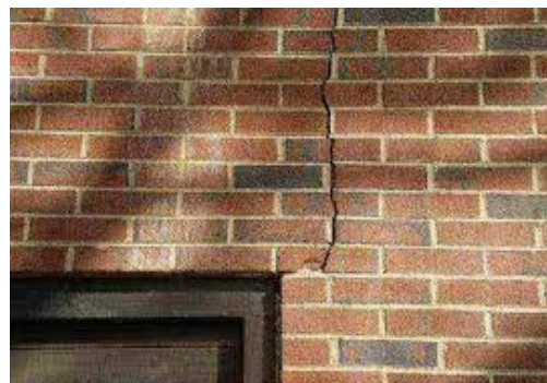
1-сурет – Кірпіш қалауда пайда болатын жарықтар:
