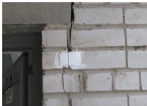
1-сурет – Кірпіш қалауда пайда болатын жарықтар:
