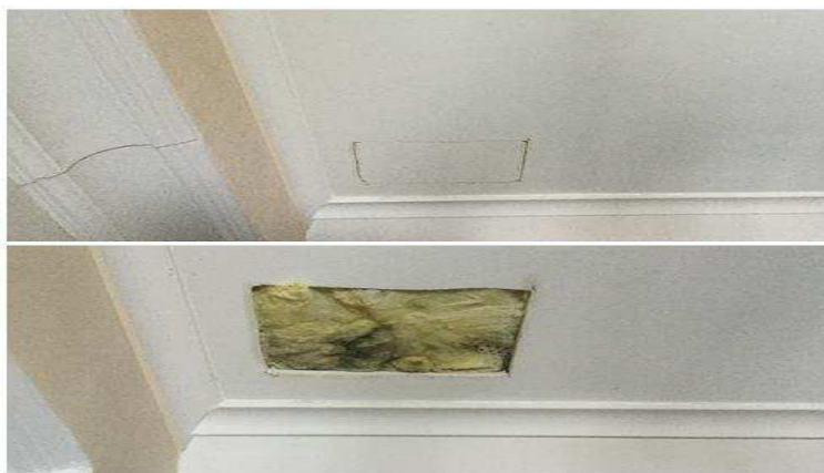
4-сурет – Гипсокартон бетінен ашу
