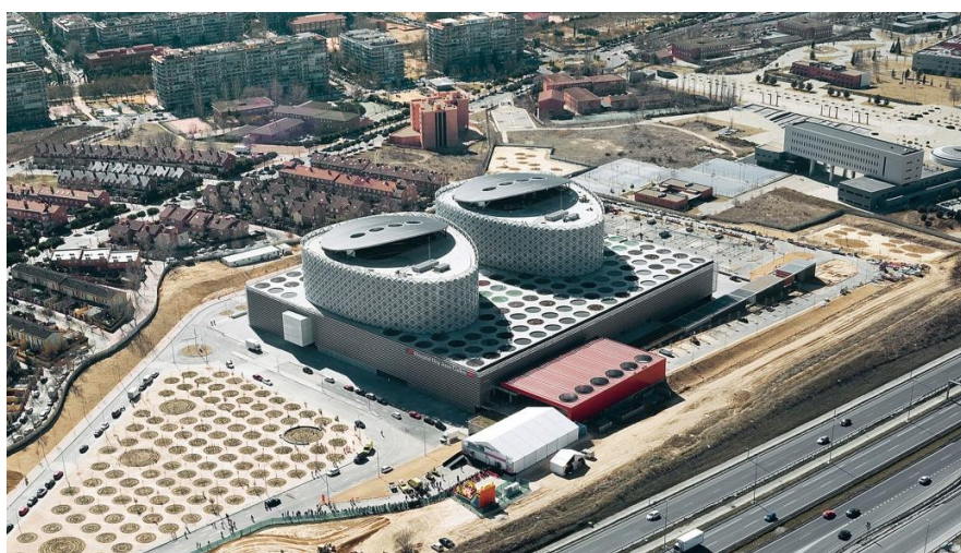
Рисунок 4 – Больница имени короля Хуана Карлоса, Мостоле, Мадрид, Испания. Rafael de La-Hoz Arquitectos, 2012 г. Фото – Tafur [4]
