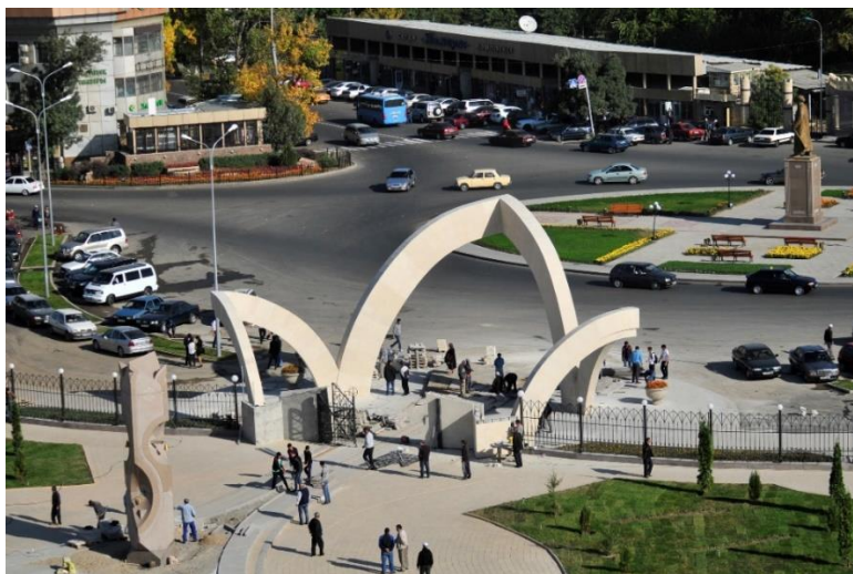
Рисунок 11 – Консольные конструкции трех арок входной группы ИКЦ «Коне Тараз». Фото Э.М. Байтенова
