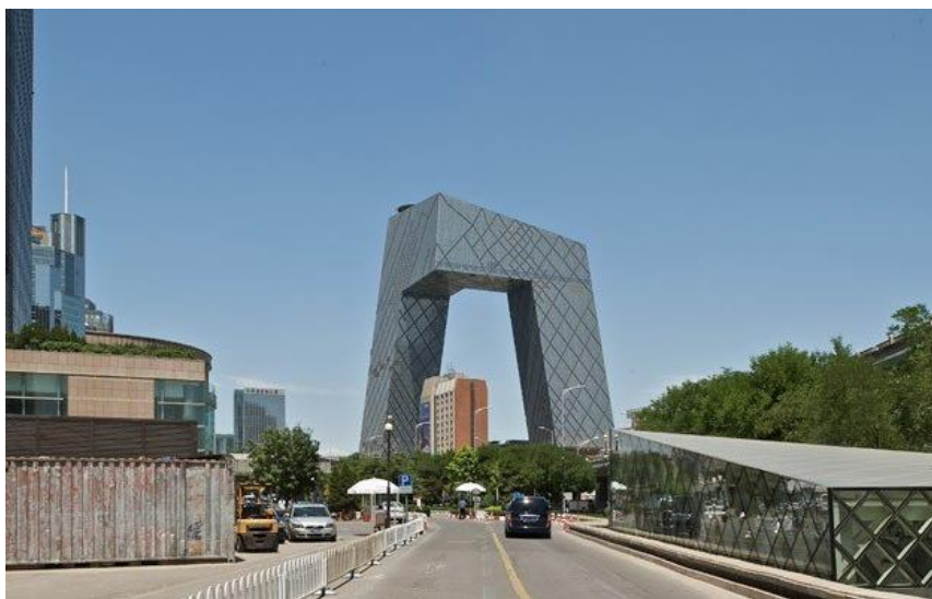
Рисунок 5 – Здание CCTV в Пекине (офис центрального Китайского телевидения), архитектурное бюро OMA [10]
