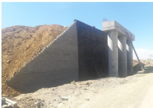
Рисунок 3 – Устой с отдельными функциями с геосинтетическими решетками на автомобильной дороге Нур-Султан – Павлодар [материалы авторов]
