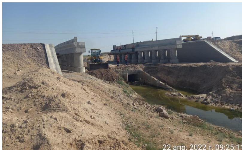
Рисунок 4 – Общий вид моста и ход строительства моста через канал Или [материалы авторов]
