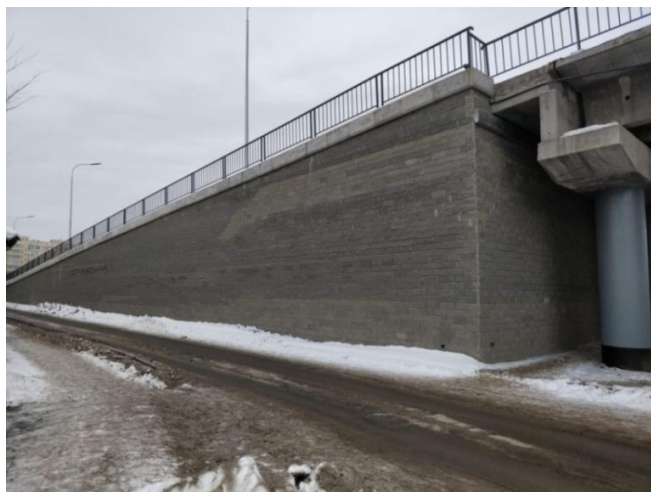
Рисунок 2 – Левобережный подход к путепроводу в г. Уральск [материалы авторов]
