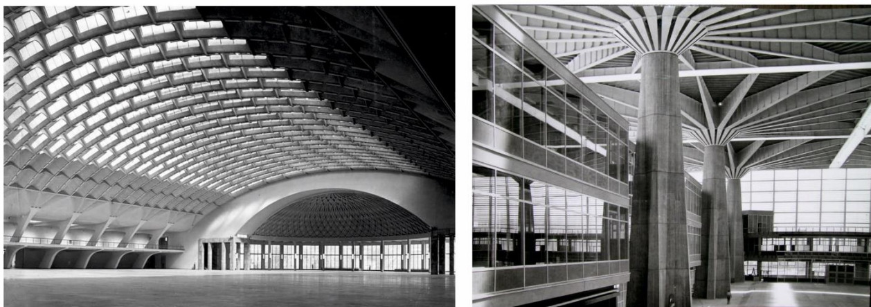
Рисунок 7 – Своды Пьера Луиджи Нерви из сборных бетонных элементов, [Источник: https://rgnp.ru/biografia-pera-nervi-biografia-nervi-pl-foto-video/ ]
