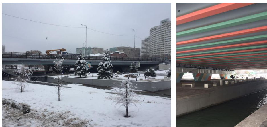
Рисунок 4 – Мост и пространство под мостом проспекта аль-Фараби [фотография авторов].
