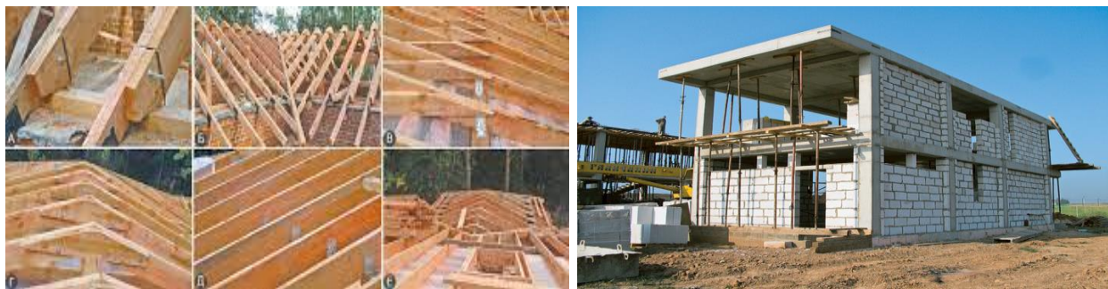
1-сурет – Шатыр мен шатырды жөндеу Рафтерлерді бекіту - рафтерлерді Mauerlat-қа қалай дұрыс бекіту керек [Дереккөз: https://krovlyakrishi.ru/wp-content/uploads/2016/12/8-4.jpg ]
