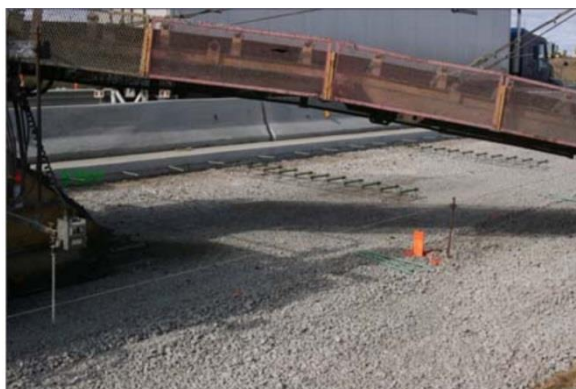
Рисунок 1 – Строительная площадка (Мичиганский университет, Анн-Арбор) [10]
