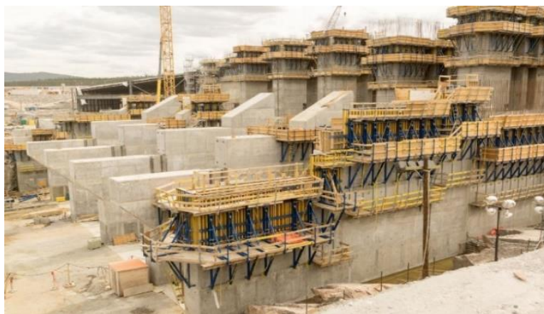
Рисунок 6 – Строительный объект Маскратского водопада [14]
