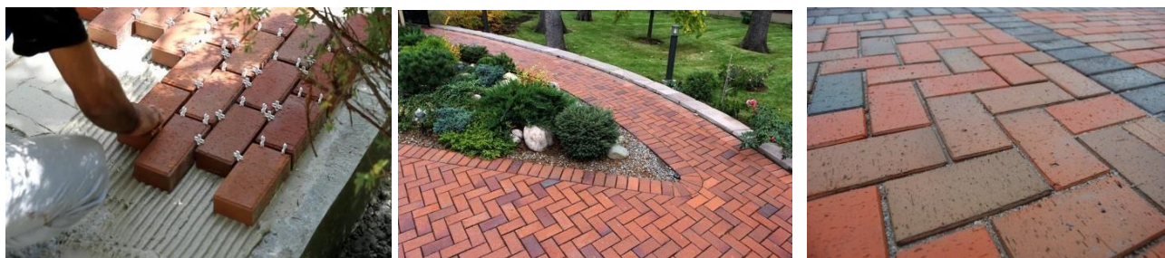
Рисунок 2 – Фрагменты тротуаров, устроенных из керамических брусчаток и плиток
