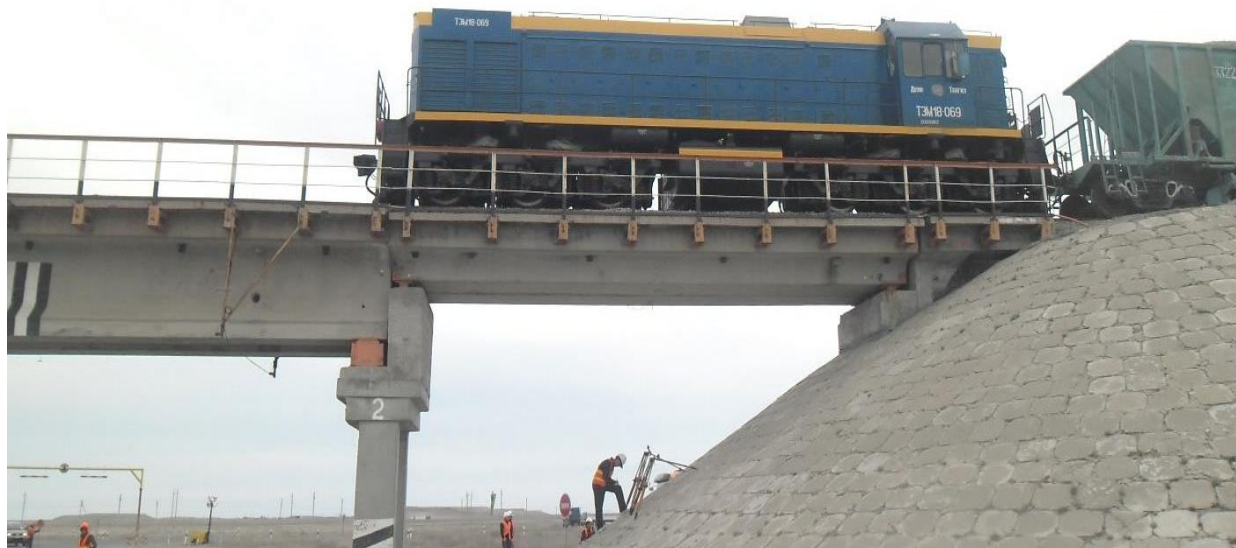
Рисунок 3 - Установка сцепа «тепловоз + вагон» на пролетное строение 2-3 (Загрузка №1)
