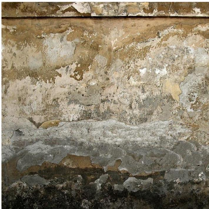
Рисунок 1 – Слой с пониженным сцеплением растворов бетона
