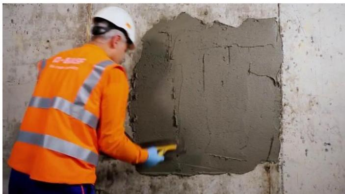
Рисунок 3 – Нанесение тиксотропного бетона
