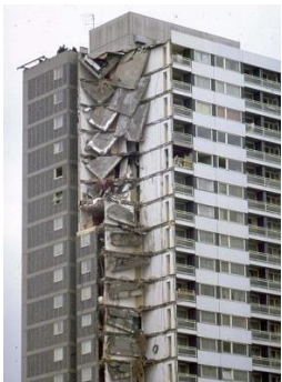
Рисунок 1 – Разрушение панельного жилого дома от взрыва газа
