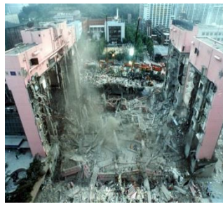
Рисунок 2 – Обрушение супермаркета в Сеуле
