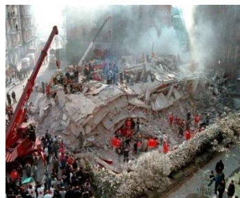
Рисунок 3 – Обрушение торгового центра в Бангладеш
