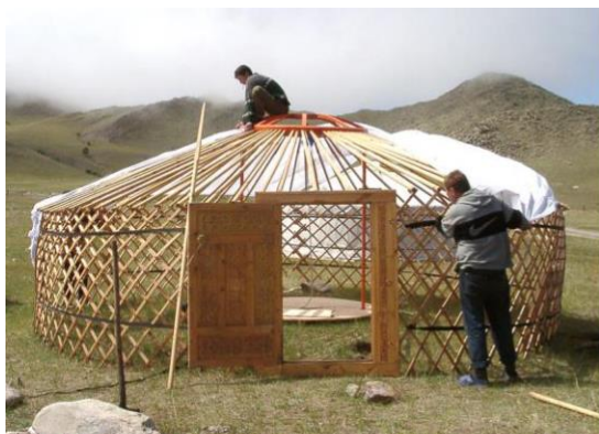
Рисунок 3 – Конструкция юрты и ее установка: 1 – кереге, 2 – шанырак, 3 – уыки, 4 – дверной косяк
