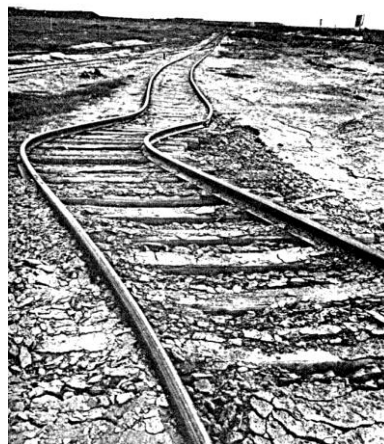
Деформация рельсового пути.
