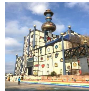
Рис. 3 – Мусорожигательный завод в Вене (Австрия)
