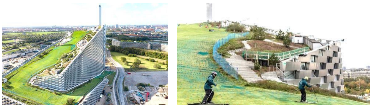
Рис. 4 – Мусороперерабатывающий завод – ТЭЦ Amager Bakke (ARC), Дания
