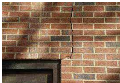
1-сурет – Кірпіш қалауда пайда болатын жарықтар:
