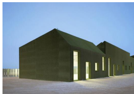
Вид на вертикальные «зеленые» стены и кровлю
