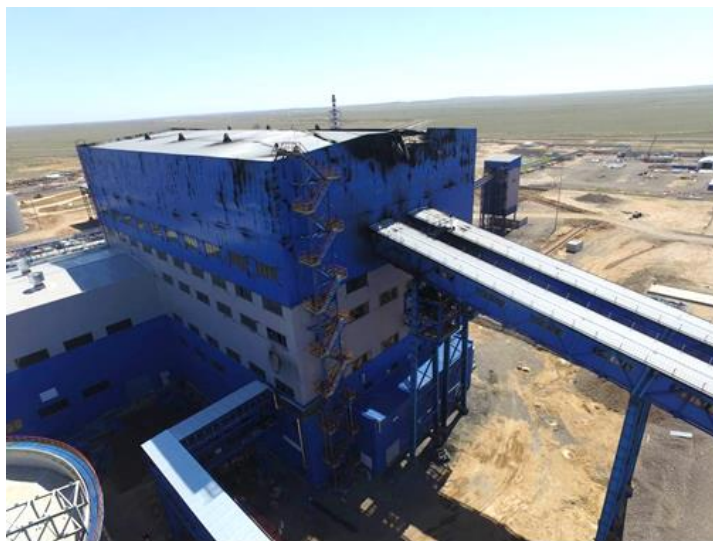
Рисунок 1 – Общий вид фасада здания в осях 15, А-К
