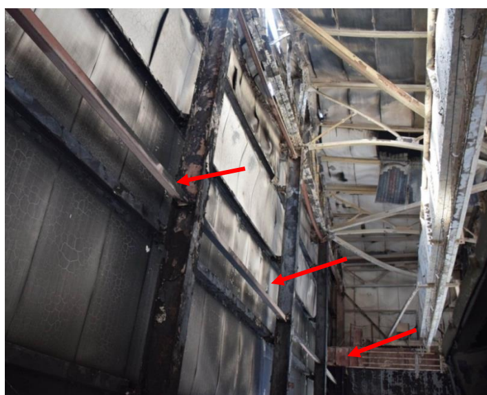
Рисунок 4 – Фахверковые колонны по ряду «К» в осях «10-14» с уровня площадки на отм. +30.300 до отм. +39.800
