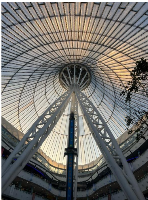
Рисунок 2 – Триподная конструкция, ТРК «Хан Шатыр» г. Астана, Казахстан, 2006 -2010. Архитектурное бюро Foster + Partners (Фото 2022 г Онищенко Ю.) [материал авторов]
