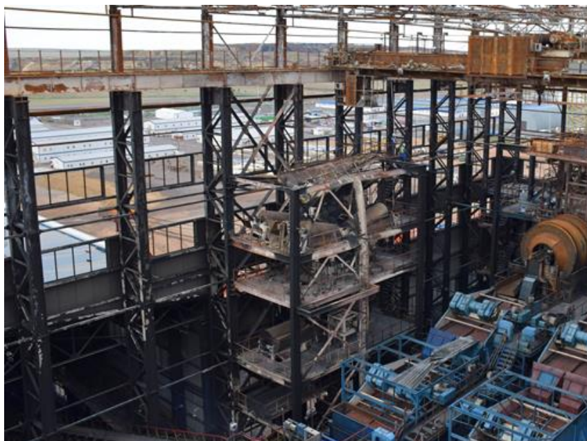
Рисунок 6 — Ограждающие конструкции (сэндвич-панели) на участке в пределах отм.+26.900 до отм. +44.150 по всему периметру Объекта демонтированы
