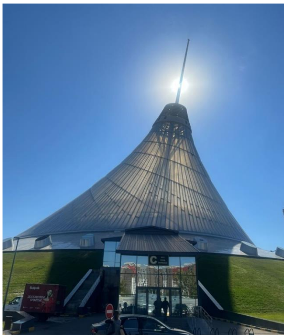
Рисунок 1 –ТРК «Хан Шатыр», вид со стороны главного входа. Астана, Казахстан, 2006 - 2010. Архитектурное бюро Foster + Partners (Фото 2022 г Онищенко Ю) [материал авторов]
