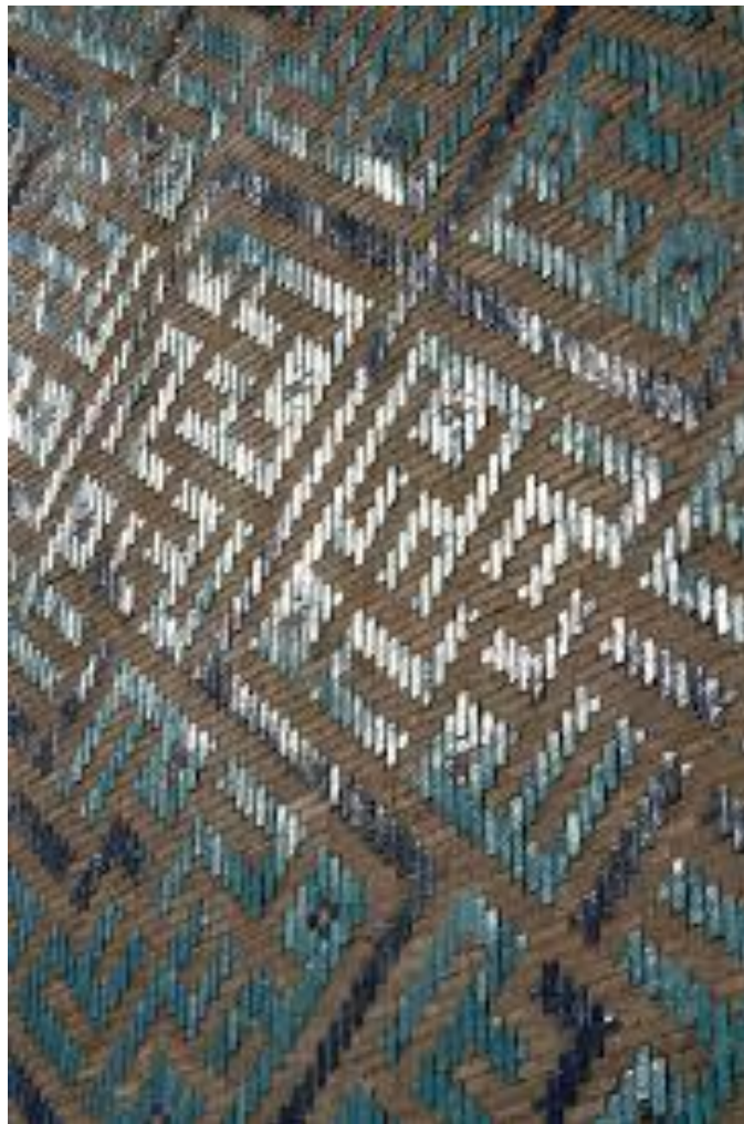
Рисунок 3 – Облицовка западного фасада. Глазурованный кирпич.
