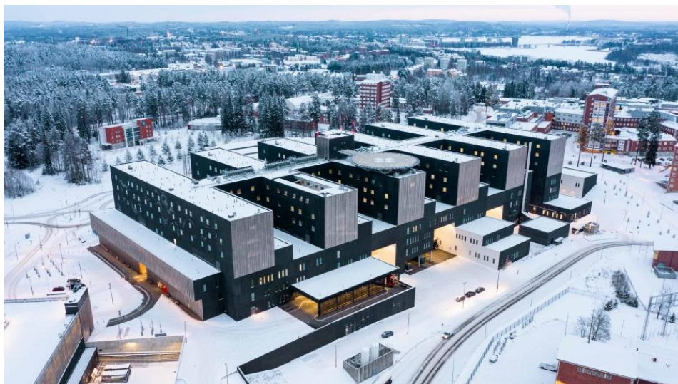
Рисунок 1 – Госпиталь Nova, Йювяскюля, Финляндия, JKMM Architects, 2020. Фото – Tuomas Uusheimo [5]
