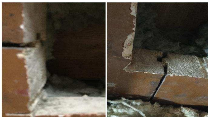
7-сурет – Шпунтты тақталардан жасалған арасындағы саңылаулар мен саңылаулардың болуы
