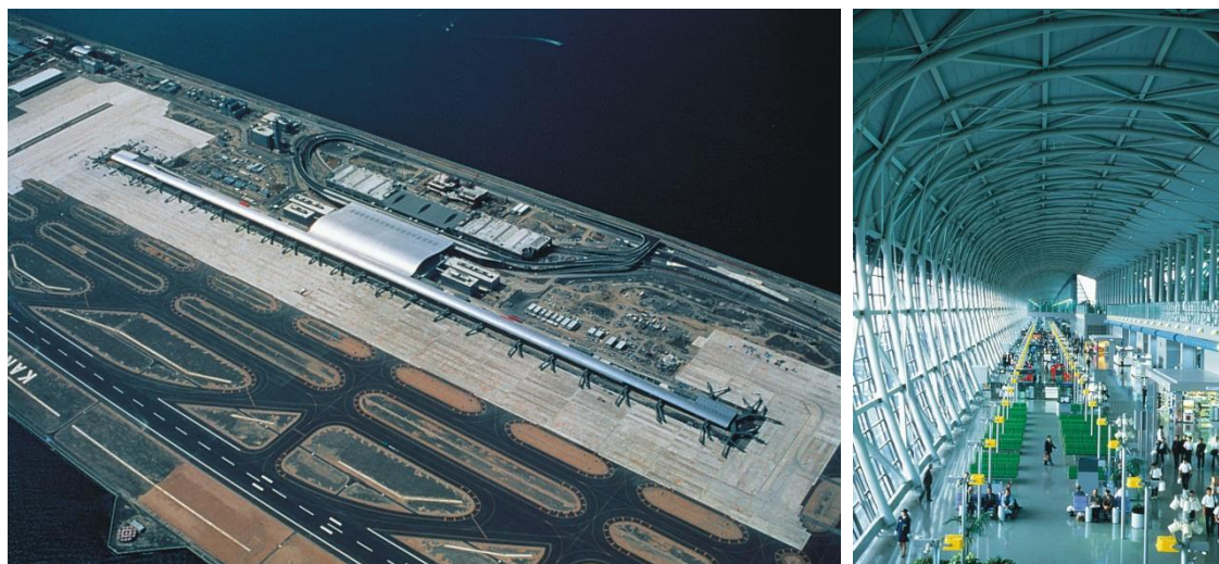
Рисунок 1 – Здание пассажирского терминала международного аэропорта Кансай Осака, Япония, 1988-1994. Строительная мастерская Ренцо Пиано, архитекторы – Н. Окабе, старший ответственный партнер в сотрудничестве с Nikken Sekkei Ltd., Aéroports de Paris, Japan Airport Consultants Inc. Заказчик: Kansai International Airport Co. Ltd. Графические материалы предоставлены официальным представителем архитектурного фонда Ренцо Пьяно [5]
