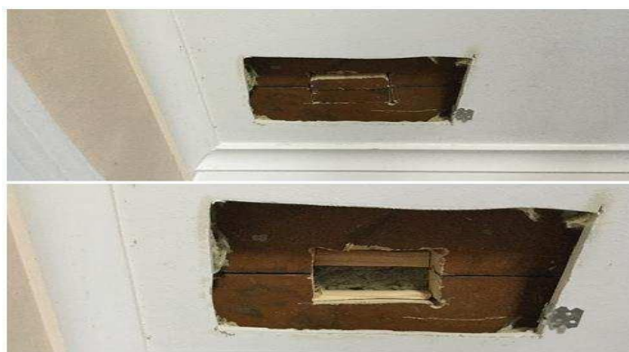
6-сурет – Шпунтты тақталардан жасалған шатыр қабатын ашу
