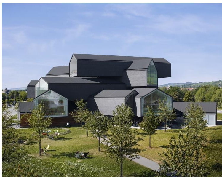
Рисунок 8 – Пятиэтажный шоу-рум Vitra Haus, Германия, с выносами консолей до 15 м. Архитектурное бюро Herzog & de Meuron [11]
