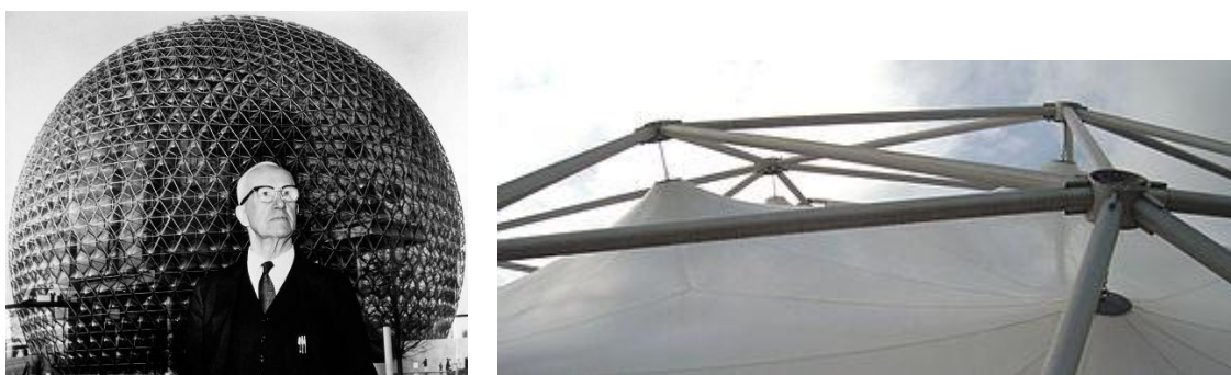
Рисунок 7 – Геодезический купол системы Б. Фуллера. [Источник: https://machined.house ]
