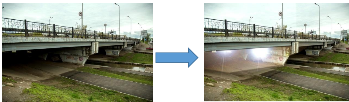
а) Существующее состояние пространства под мостом
