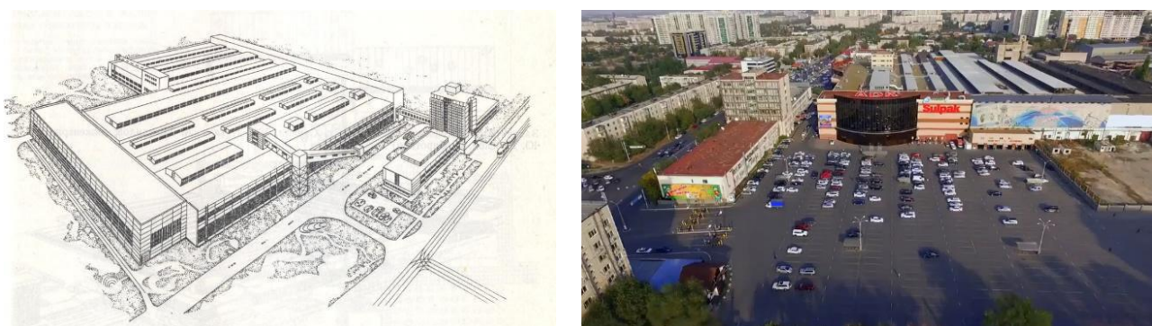
Рисунок 5 – Главный корпус Алма-Атинского домостроительного комбината а) схема Алма-Атинского домостроительного комбината 1953г.; б) вид на главный корпус - 2018 год [Источник: https://2gis.kz/ , https://vlast.kz/kz/gorod/18589-mikrorajony.html ]
