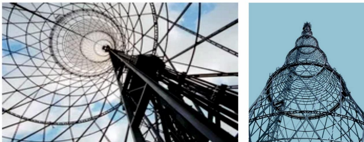
Рисунок 6 – Сетчатая башня-оболочка конструкции В.Т. Шухова 1924г. [Источник: http://moscowchanges.ru/wp-content/uploads/2017/08/Shukhov_tower_01.jpg ]
