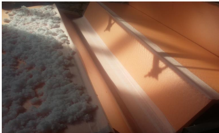
4-сурет. Пеноплекстен жасалынған трапецияқималы арна
