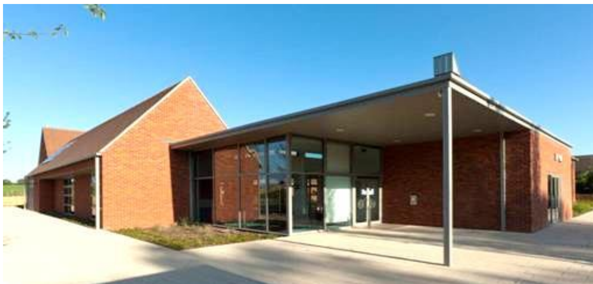
Рис. 1. Положительный пример организации входной группы в школьное здание. Здание посажено с учетом требований безбарьерной среды (отсутствует перепад высот при входе). Крупный навес выполняет функцию визуального ориентира входной группы и обеспечивает достаточное укрытое пространство [3].
