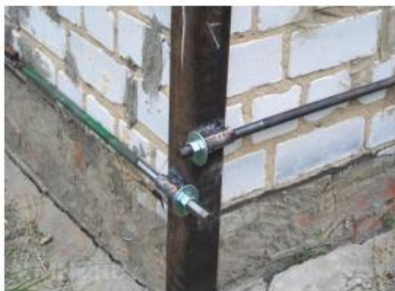
Рис. 4. Узел сопряжения элементов усиления
