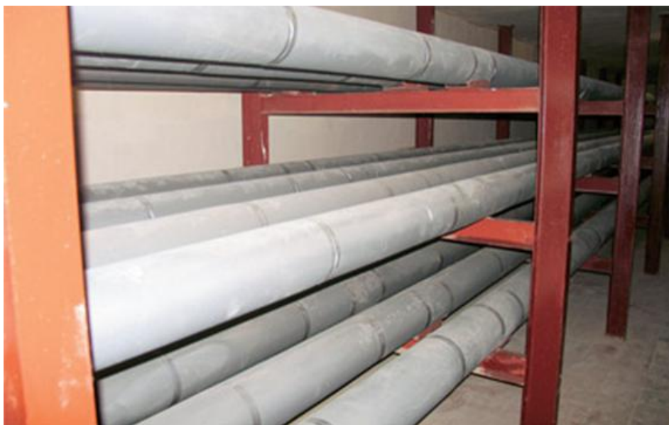
Рис. 1. Прокладка магистралей в техническом коридоре
