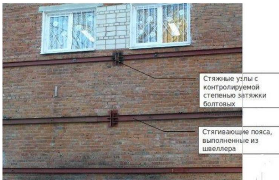
Рис. 4. Усиление наружной стены напряженными поясами из стали
