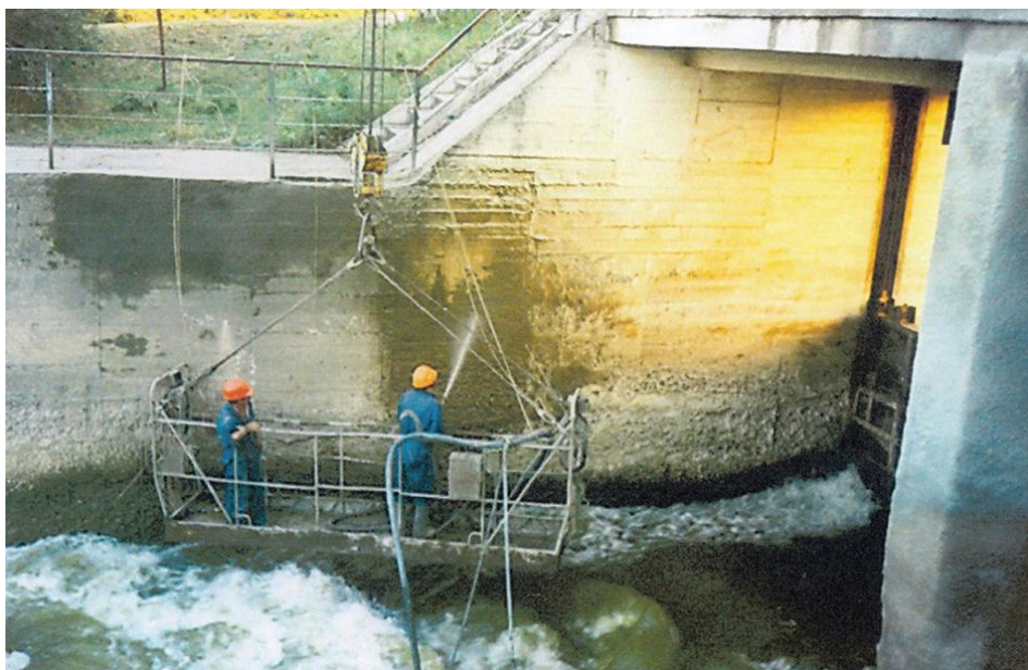
Рис. 3. Восстановление монолитных железобетонных конструкций Покойненской плотины
