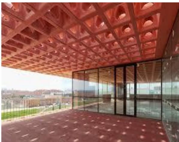
Рис. 2. Кессонные перекрытия, Испания
