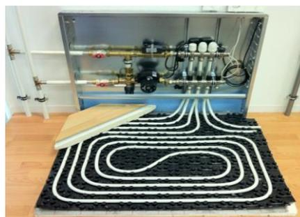
Рис. 6. Шкаф управления системой напольного отопления
