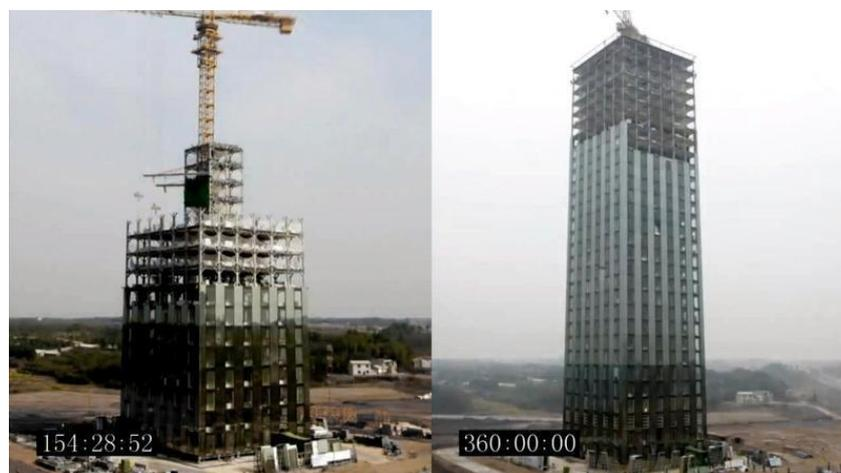
Рис. 3. 30-этажный отель в Китае, построен в 2011 году за 15 дней из модульных элементов конструкции
