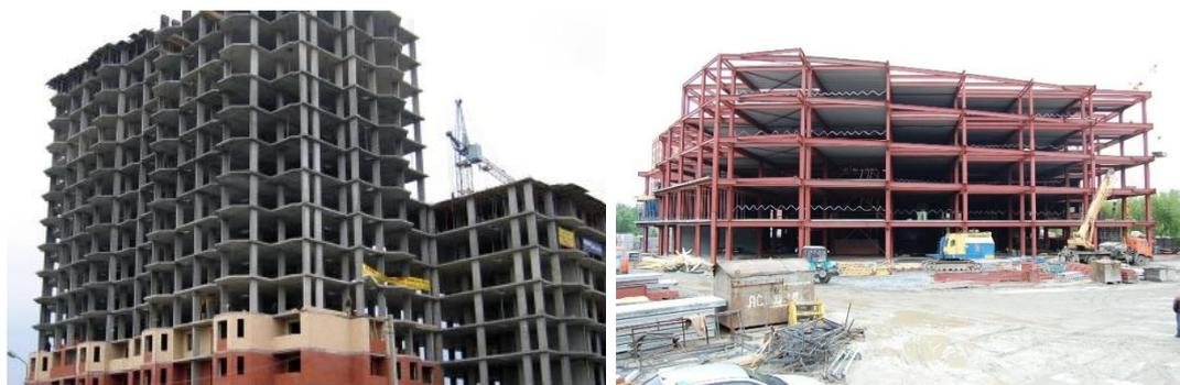
Рис. 2. Железобетонный и металлический каркасы зданий
