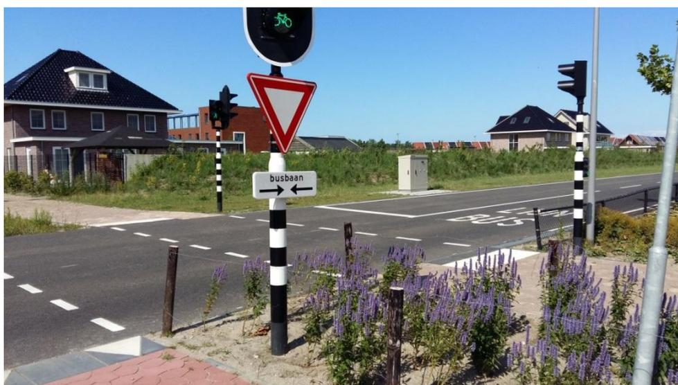
Рис. 2. По центру проходит выделенная двухпутная полоса для автобусов; перпендикулярно к ней слева – велосипедная дорожка, справа для пешеходов (со своими регулируемыми светофорами). Автомобильное движение осуществляется по двухпутной полосе правее автобусной. Фото Г.А. Исабаева
