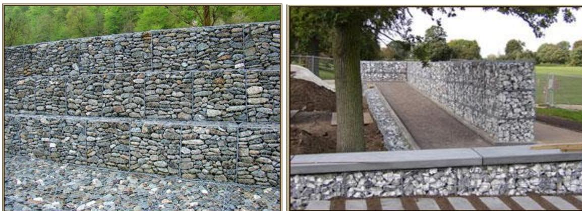
Рис. 1. Примеры устройства габионных подпорных стенок при строительстве
