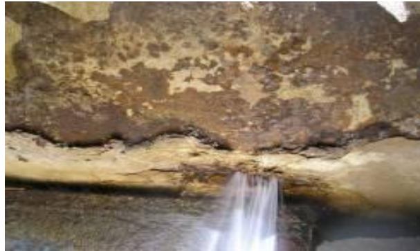
Рис. 3. Пример аварийной течи из трубопровода
