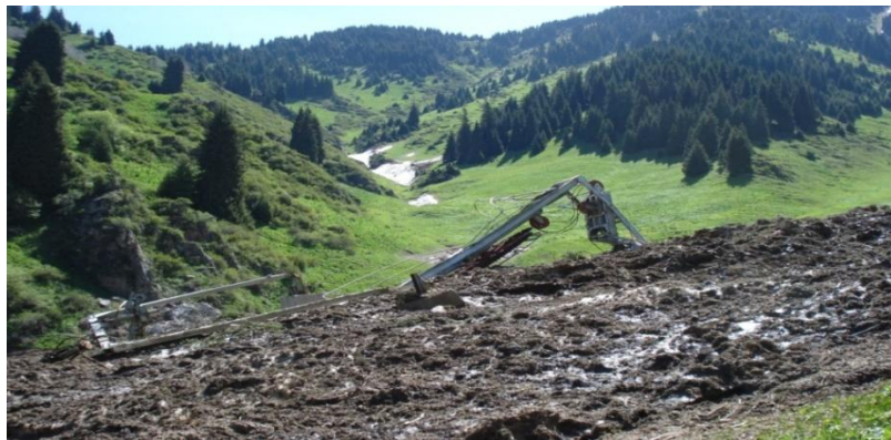
2-сурет. Алматау тау шаңғысы курортындағы ылғалды көшкін арқанды жолдың жоғарғы станциясын жарамсыз етті.
